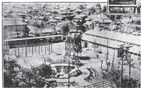
写真4 噴水塔の全景
