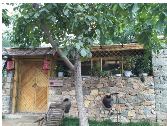
写真 5-9 民宿に改造された空き家の外部様子 筆者撮影
